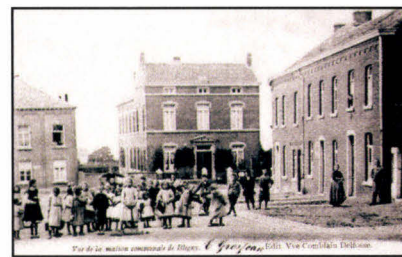
Vue de Blegny, province de Liège vers 1900.
